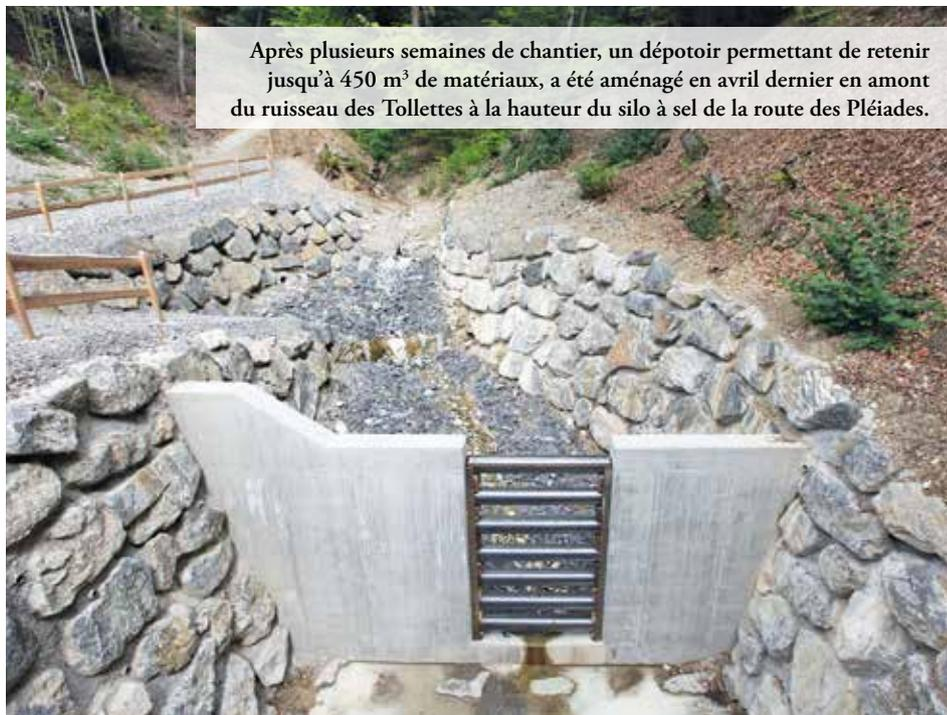
Après plusieurs semaines de chantier, un dépotoir permettant de retenir jusqu'à 450 m<sup>3</sup> de matériaux, a été aménagé en avril dernier en amont du ruisseau des Tollettes à la hauteur du silo à sel de la route des Pléiades.
